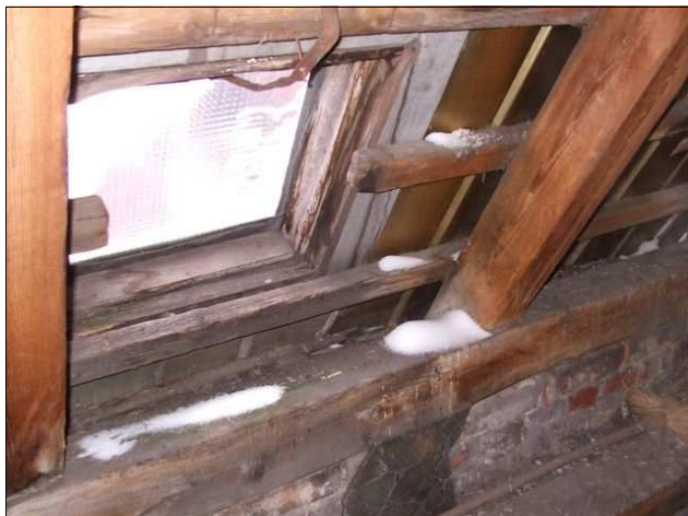
foto /17/ Výlez na plochou střechu, nafoukávání sněhu netěsnostmi kolem výlezu do půdního prostoru
