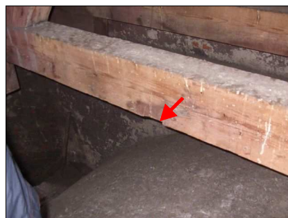
foto /14/ Sonda S5 – vazný trám
