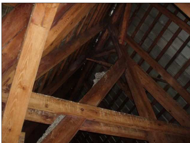
foto /27/ Hromadící se ptačí trus na prvcích krovu
