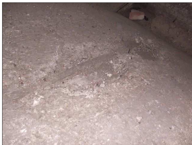
foto /15/ Krov u střední věže, viditelné znečištění ptačím trusem
