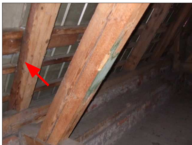
foto /28/ Tmavší odstín patrný na více krovkách na straně u střešní krytiny – projev zatékání netěsnostmi ve střešní krytině
