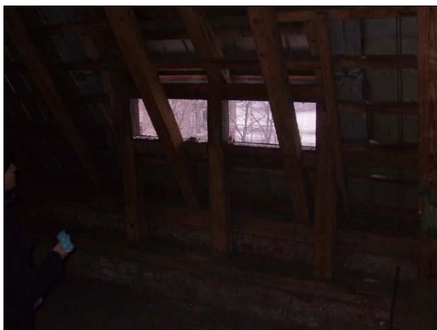
foto /35/ Pohled na jeden z vikýřů, nad otvorem je viditelné prosvítání mezery mezi výměnou a krytinou
