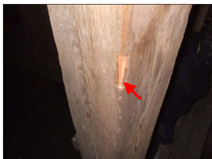
foto /13/ Sonda S4 – sloup střední věže
