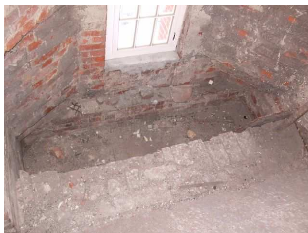
foto /34/ Pohled do západní věže
