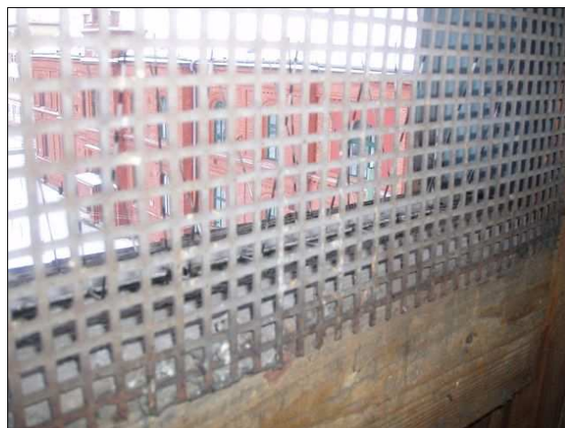
foto /36/ Ocelová mřížka na jednom z vikýřů
