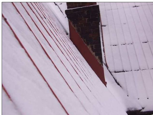
foto /31/ Lemování komínového tělesa – pohled z boční strany
