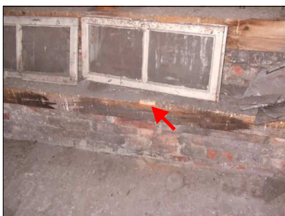
foto /5/ Sonda LP2 – pozednice pod vaznými trámy
