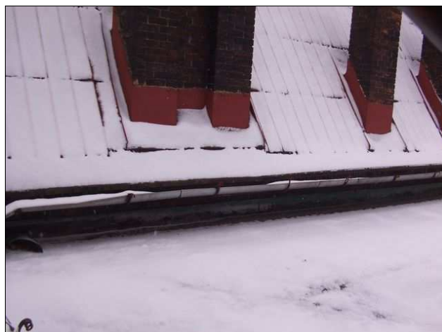
foto /20/ Pohled na část ploché střechy a na lemování komínových těles
