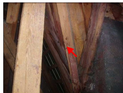
foto /6/ Sonda LP3 – úžlabní krokv
