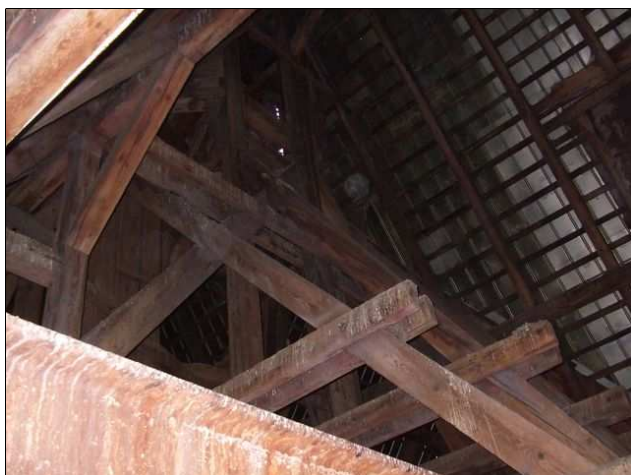
foto /15/ Krov u střední věže, viditelné znečištění ptačím trusem
