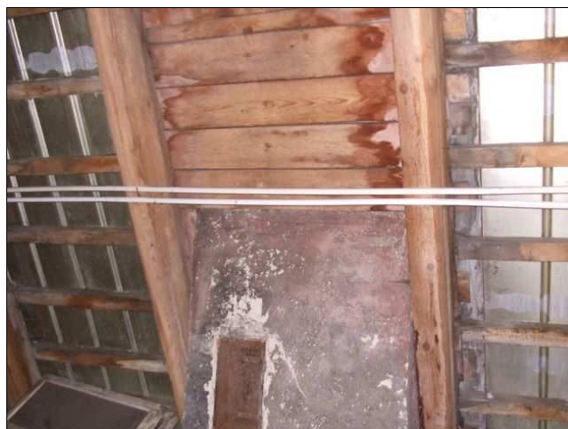
foto /32/ Plošné bednění pod lemováním komínového tělesa
